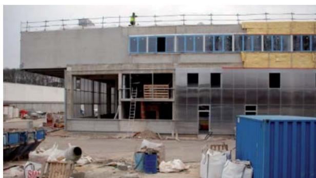
Le polycarbonate\* et l'isolant viennent recouvrir la structure
