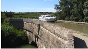
L'eau du Canal coule **SUR** le pont, et l'eau de la rivière coule **SOUS** le pont : c'est un **PONT CANAL** (Pont Canal du Répudre à Paraza)
