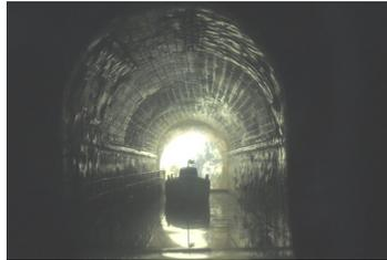
Le **Tunnel du MALPAS** est le 1er tunnel navigable en Europe : il y a de l'eau dedans et les bateaux le traversent en glissant dessus, toujours tirés par les chevaux qui marchent sur le chemin de halage que tu vois sur la gauche .
