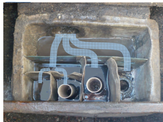
Répartition de l'eau de la source Hodierna
