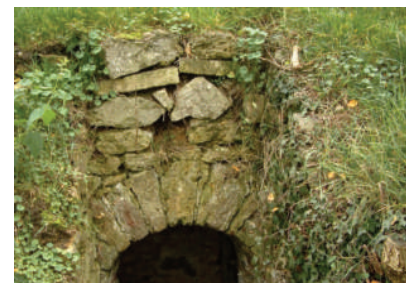
Entrée du Réservoir des Folies
